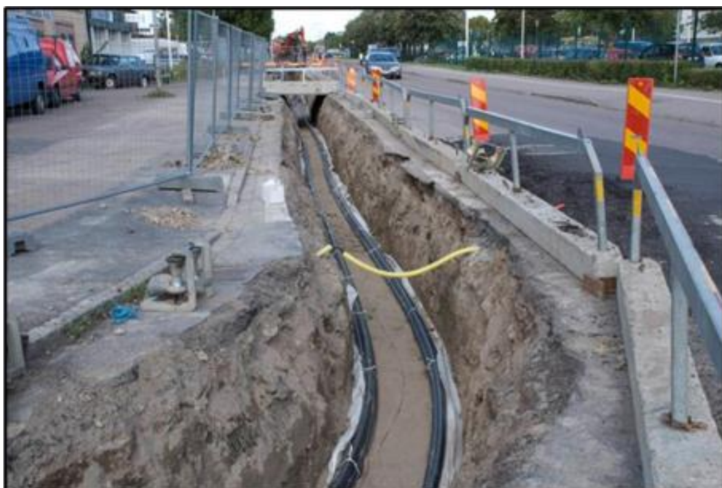
Figur 4-2. Schakt i stadsmiljö i vägbana.
